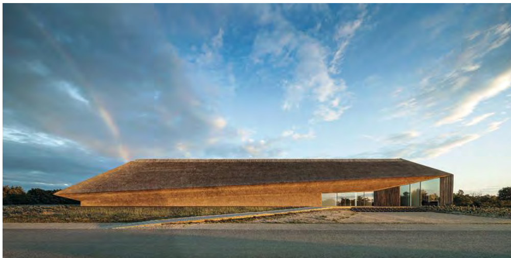
Afbeelding 105: Rieten dak doorlopend in gevel (Detail, 2017)
