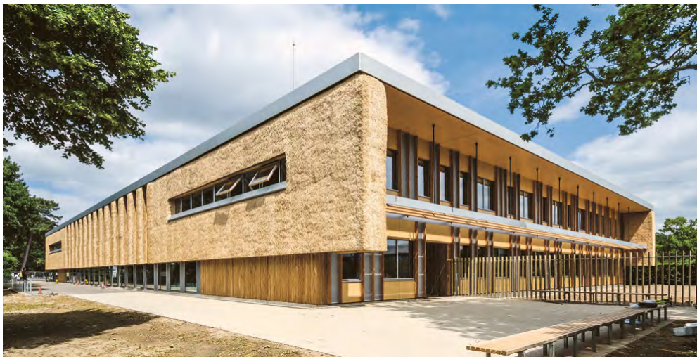
Afbeelding 101: Rieten gevelafwerking (Detail green, 2016)
