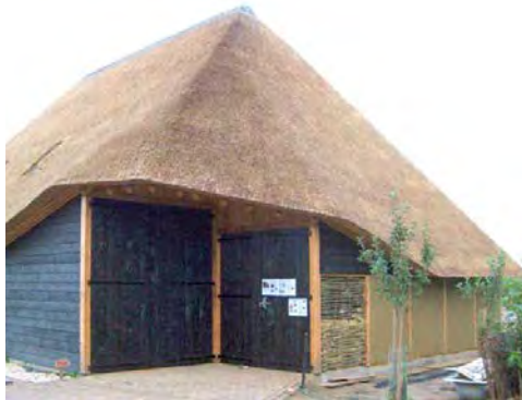
Afbeelding 117: Woning met rechts de muur uit gevlochten wilg met mengsel van leem (De Groot, 2019)
