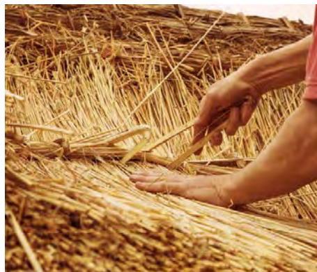
Afbeelding 80: Opbouwen rieten dak (Stevens Master Thatcher, z.d.)
