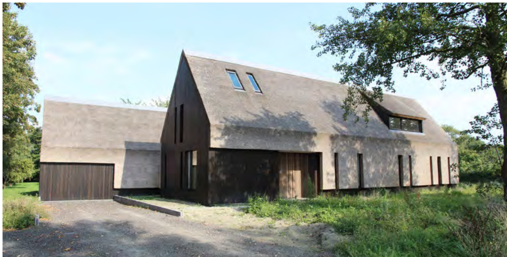
Afbeelding 104: Rieten dak doorlopend in gevel (Sánchez, 2021)
