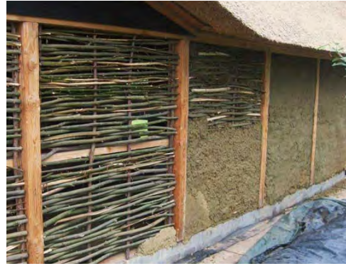
Afbeelding 118: Muur uit gevlochten wilg met mengsel van leem (De Groot, 2019)
