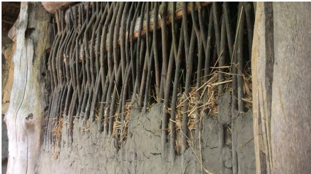
Afbeelding 119: Muur uit gevlochten wilg met mengsel van leem (De Groot, 2019)
