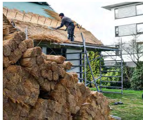
Afbeelding 81: Opbouwen rieten dak (Oude Wesselink Rietdekkers, z.d.)
