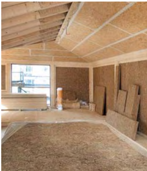
Afbeelding. 27: Lisdodde-panels als isolatie ((Van Duursen en Nieuwenhuijs, 2016)
