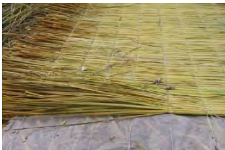
Afbeelding 31: Schikking rietstengels (Hýšková et al., 2020)
