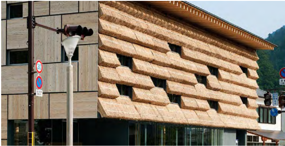
Afbeelding 100: Rieten gevelpanelen (Ross, 2020)
