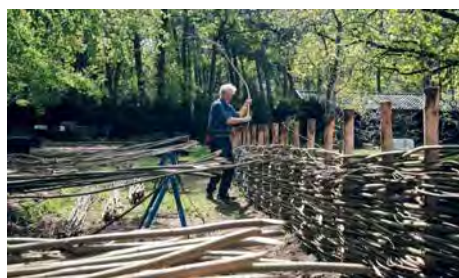
Afbeelding 109: Weven van wilgentenen tot schutting (Stoel, 2020)
