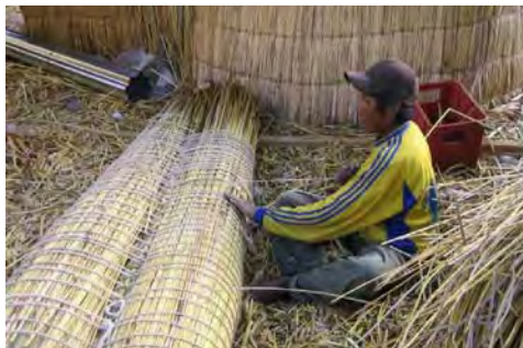
Afbeelding 90: Vlechten van riet tot pilaren (Watson, 2019)
