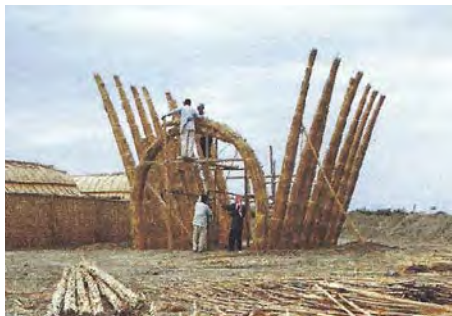
Afbeelding 92: Constructie van bundels tot structuur (Watson, 2019)
