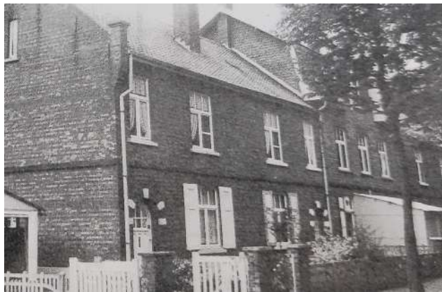
Figuur 66. Logementshuis uit de tweede fase. C. G. De Dijn. (1979).
