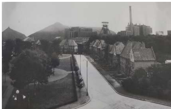
Figuur 79. Kioskplein bij de aanleg ervan. Bert Van Doorslaer. (2012).
