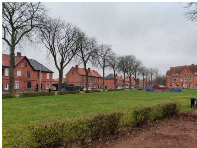
Figuur 3. Huidige staat van de arbeiderswoningen. Eigen beeldma-teriaal.
