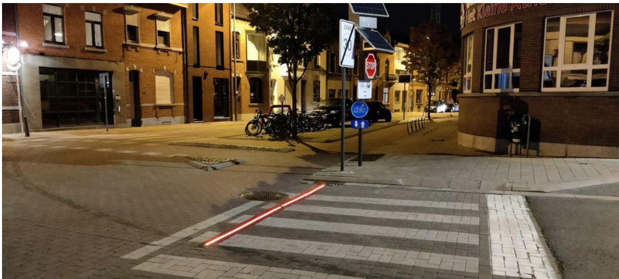
Figuur 7: Signco fietsoversteek met brandende led-strip, bron: eigen werk
