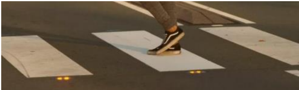
Figuur 3: led-signalering bij zebrapad, bron: (Traffic-Care, z.d.)
