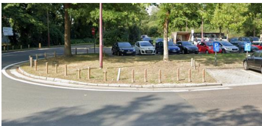
Figuur 123: Voorbeeld van het verhinderen van de toegang voor foutparkeerders (Eigen werk, 2022)
