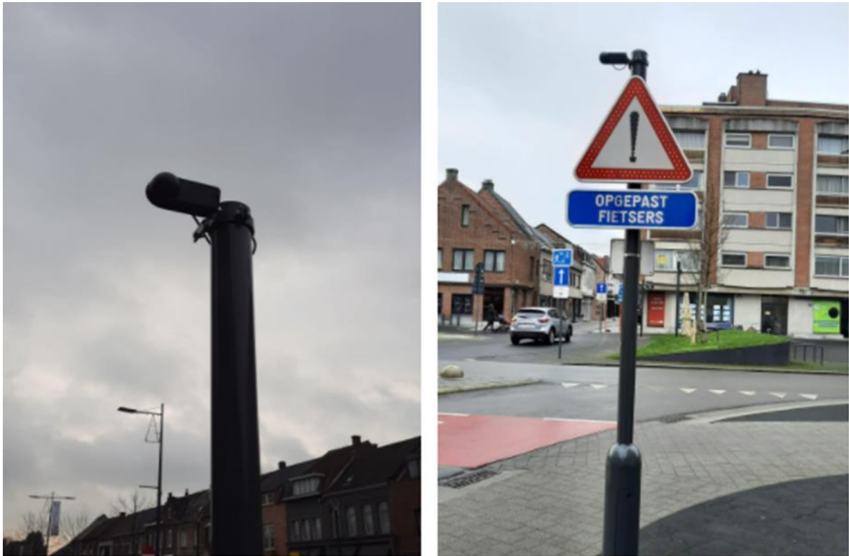
Figuur 4: Radar sensor + verkeersbord (bron: eigen werk)
