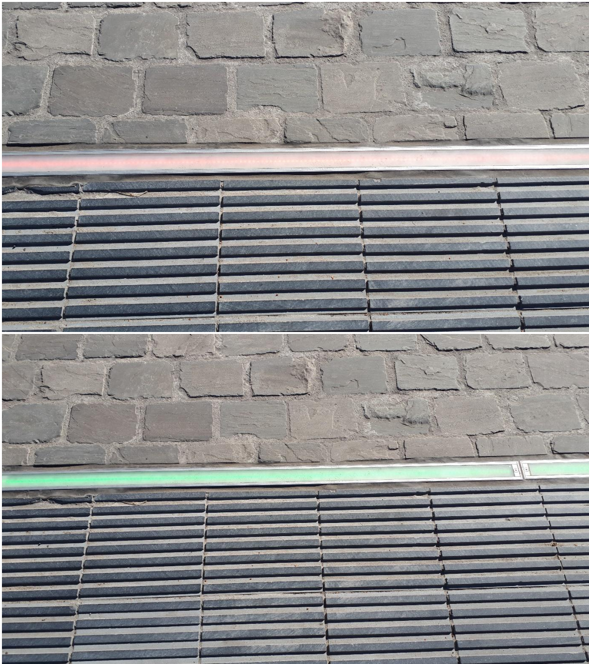
Figuur 3: Close-up van de ledstrip in het rood (boven) en het groen (beneden)
