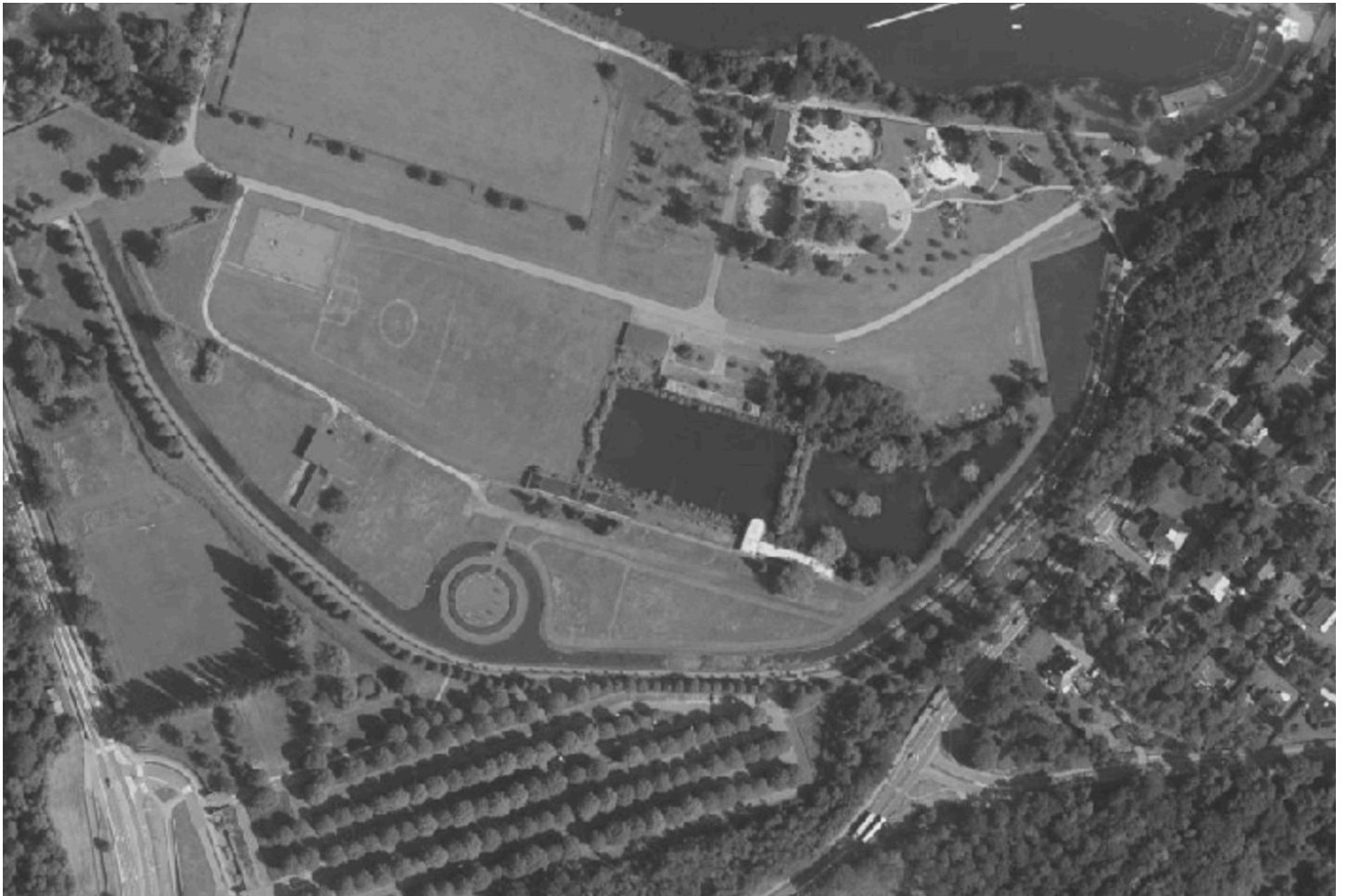
Afb. 38 Huidige situatie openluchtwembad van Hofstade
