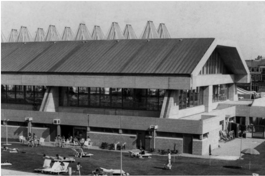
Afb. 33 Stedelijk zwembad Oostende in gebruik, ca. 1980
