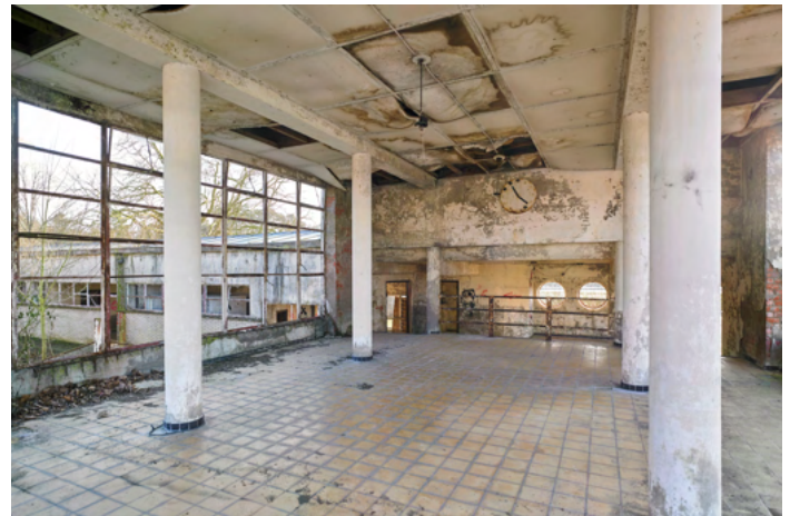
Afb. 11: Resultaat van de degradatie in het cafetariagebouw
