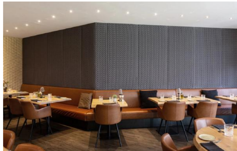
Figuur 49: Akoestische panelen als wandafwerking. (De Grande, z.j.)
