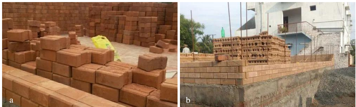
Figuur 8: Samengedrukte aardeblokken [18]
