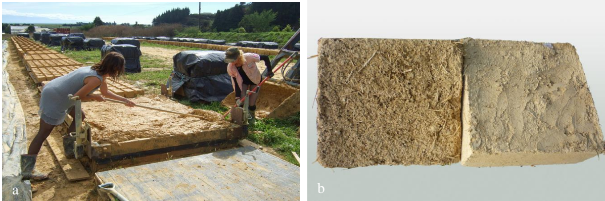
Figuur 7: a) vervaardigen adobe kleiblokken [17] en b) visualisatie adobe blokken [18]
