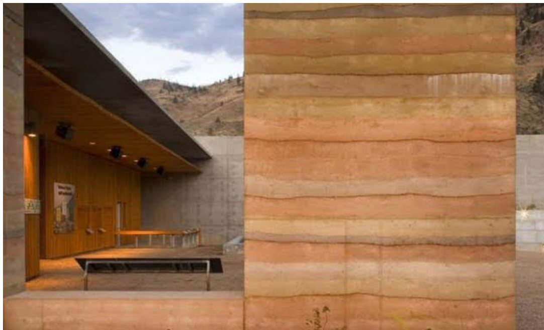
Figuur 4: Visualisatie rammed earth [11]
