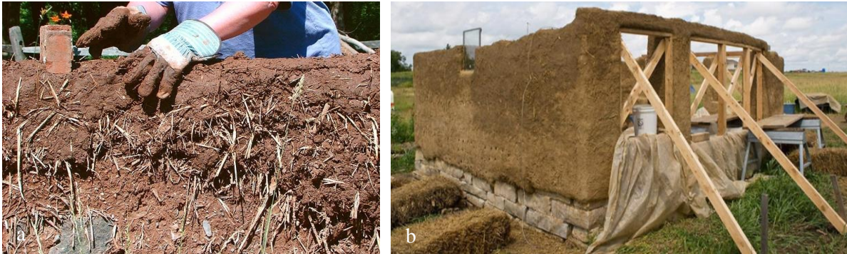
Figuur 5: a) vervaardigen muur uit cob [12] en b) visualisatie cob [13]
