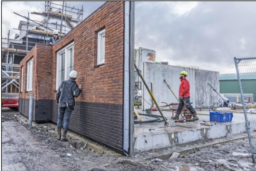
Figuur 22: Plaatsing Gevelklaarsysteem van Spaansen [38]
