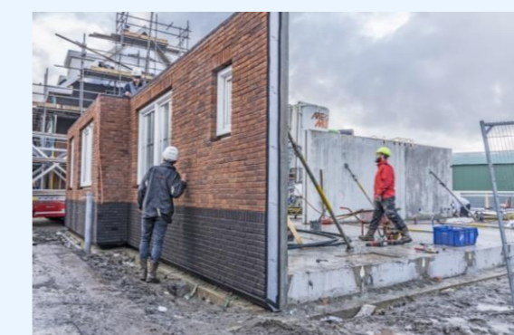
Figuur 5: Opbouw gevelklaar [4]
