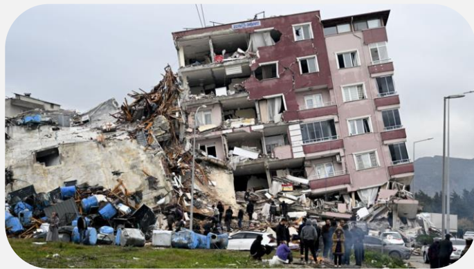
Figuur 1: RTL nieuws (7/02/2024) Flats storten in als kaartenhuis: weinig gebouwen aardbevingsbestendig [1]
