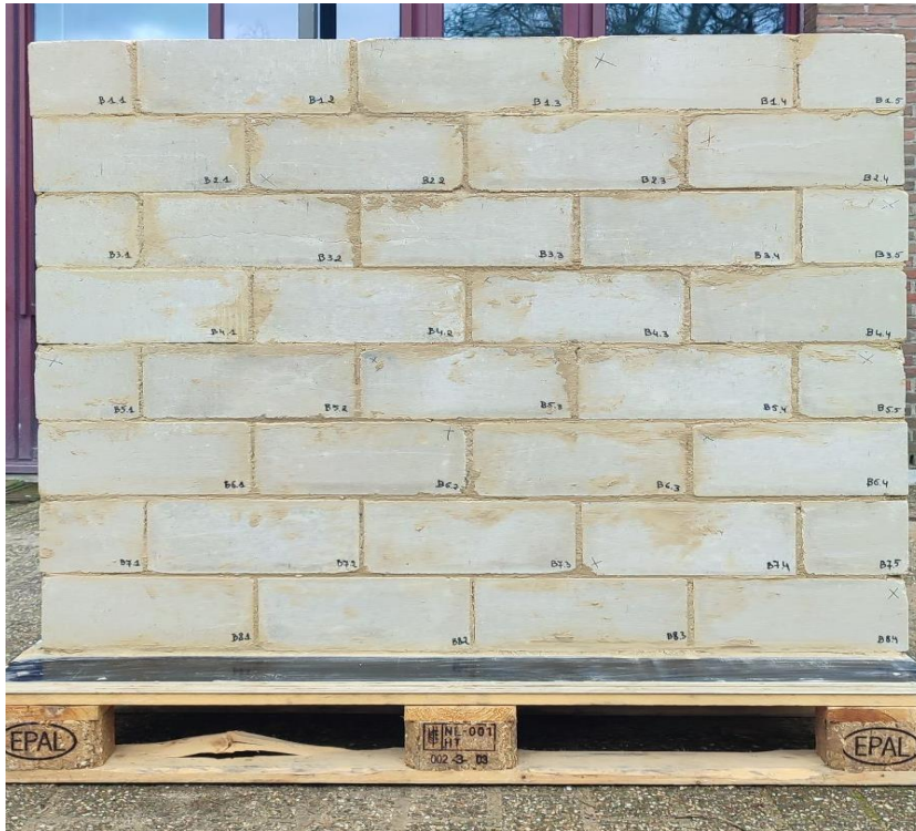
Figuur 17: Proefopstelling manuele demontage voor persstenen in verticaal strekverband
