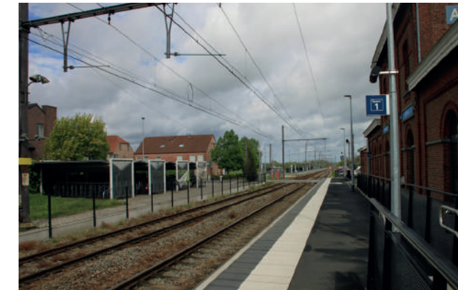
Fig. 57 - Oversteek sporen Fig. 58 - Volle parking Fig. 59 - Perron en overdekte fietsenstalling
