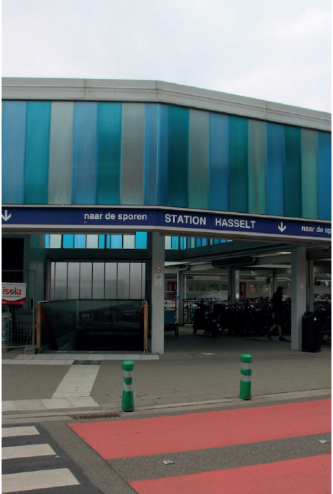
Fig. 28 - Overdekt perron Fig. 29 - Voetgangerstunnel
