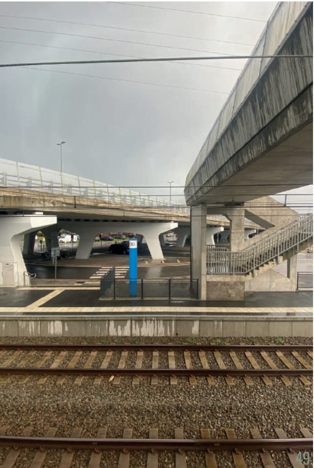
Fig. 38 - Fietspad en toegang tot perron 1 Fig. 39 - Loopbrug tussen sporen
