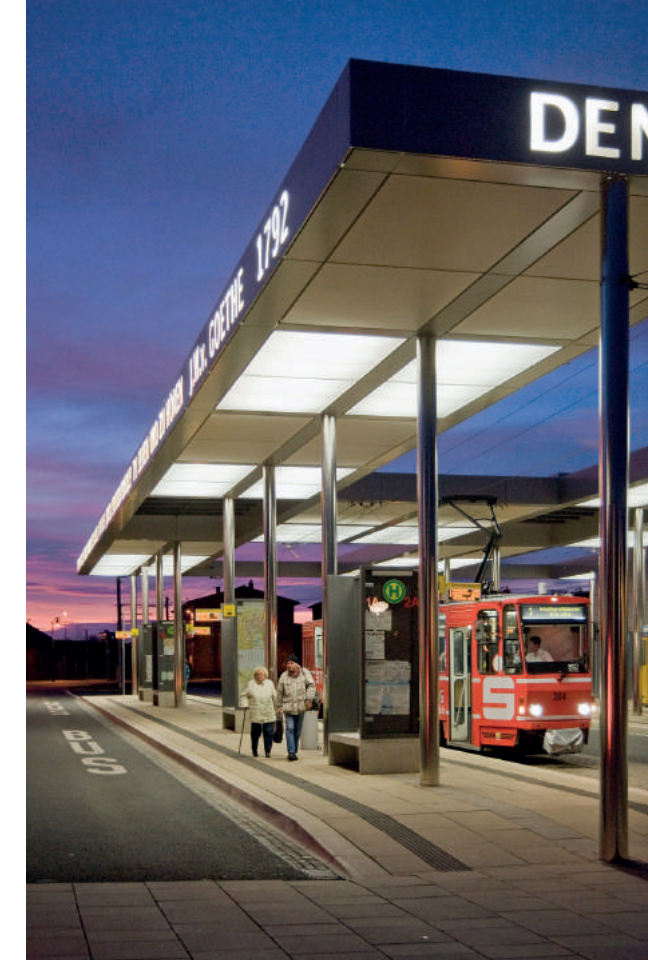
Fig. 13 - Toegang tot multimodaal kruispunt Fig. 14 - Tramhalte
