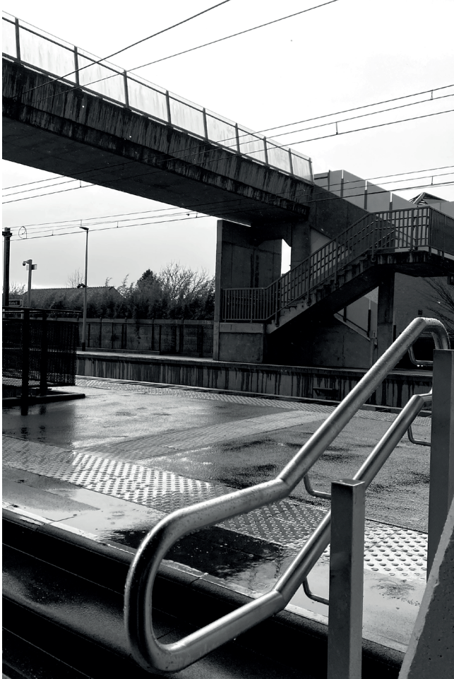
Fig. 36 - Overdekte fietsenstalling Fig. 37 - Toegang tot perron 1
