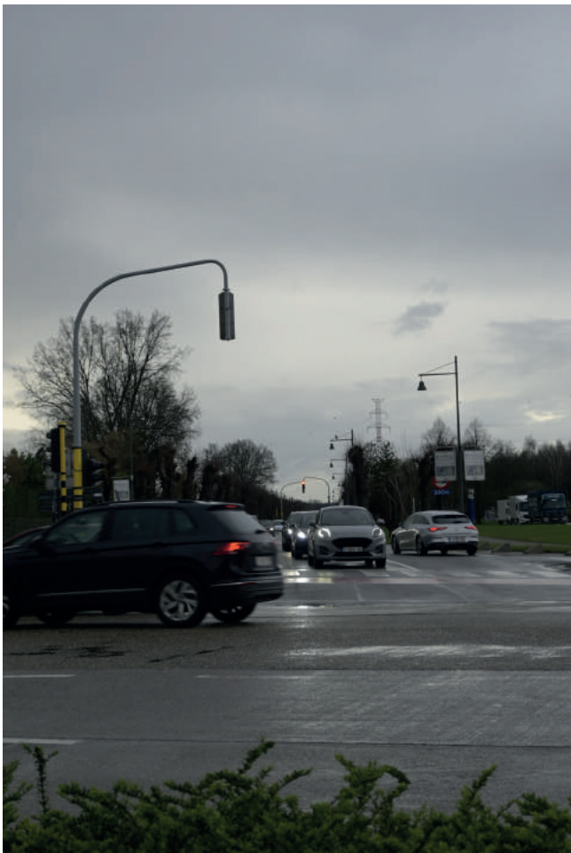
Fig. 68 - Zicht op Diestersteenweg Fig. 69 - Knooppunt steenweg en dreef
