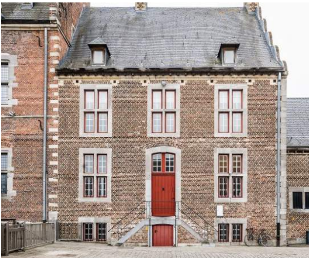
Fig. 6: Portierswoning Herkenrode site - LUCID
