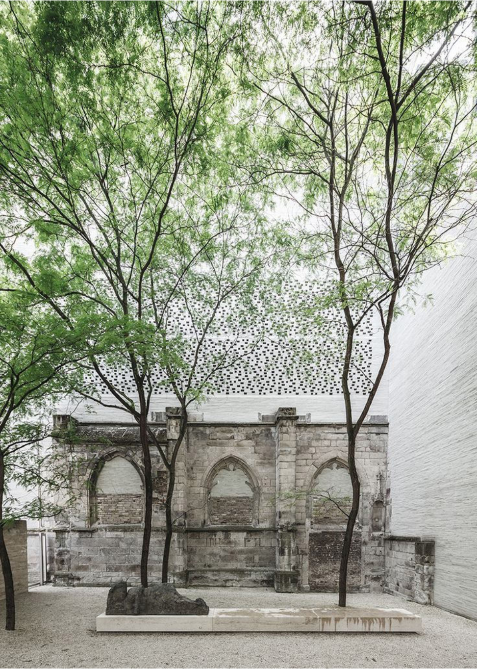
Afb. 66, Rechts: Hjortshøj, R. Exterieur van Kolumba Museum ontworpen door Peter Zumthor . Geraadpleegd op https://divisare.com/projects/349228-peter-zumthor-rasmus-hjortshøj-kolumba-museum
