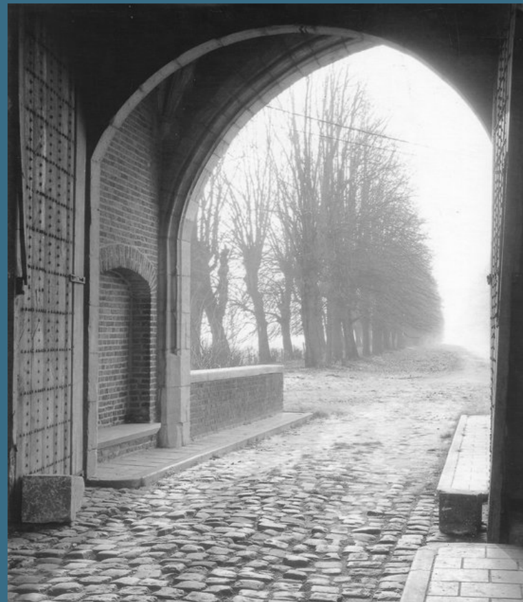
Afb. 2: Ingang door het poortgebouw met zicht op de dreef. Van Der Eycken, M. (2002). Herkenrode: abdij en levend monument .
