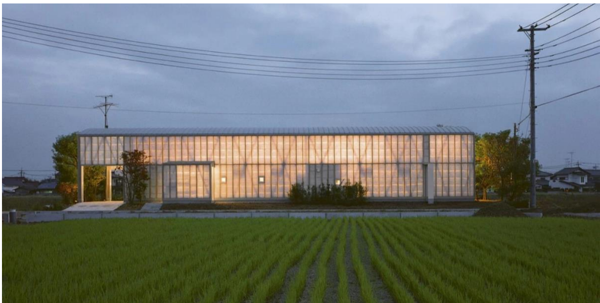
Figuur 27: Buitengevel van het Naked House (Hirai, z.d.)
