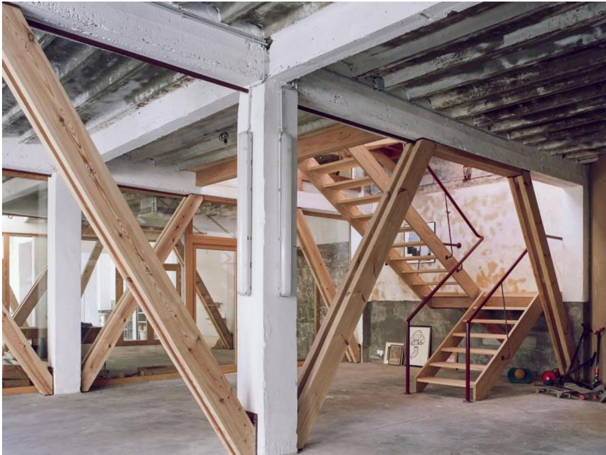
Figuur 17: 'Houten benen' constructie huis Verbiest (Malaud, z.d.)
