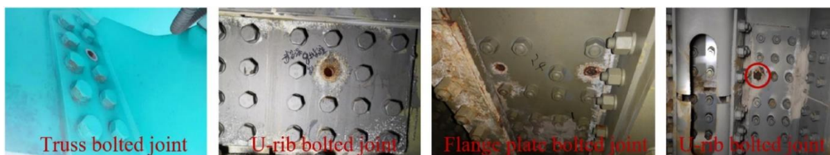
Figuur 3: Falen van boutverbindingen in stalen bruggen [4]
