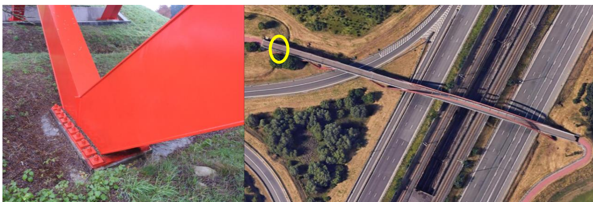
Figuur 14: Verbindingen steunpunten
