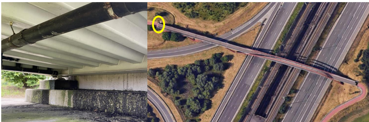
Figuur 11: Oplegging brug
