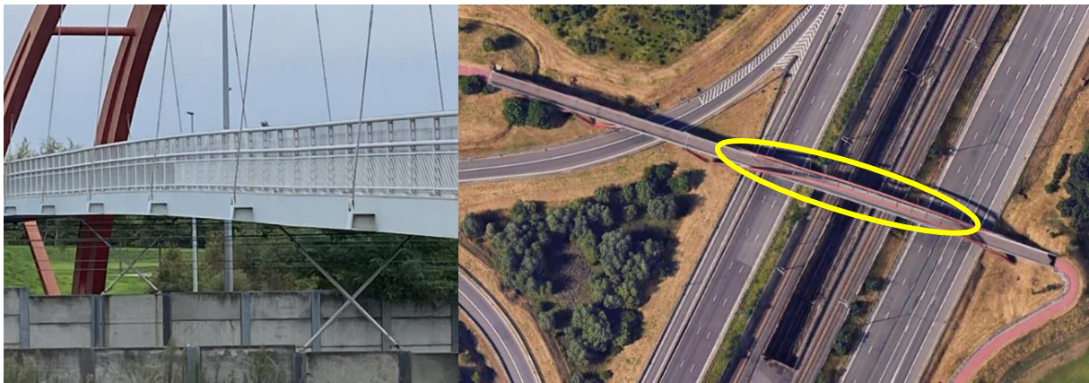
Figuur 16: Windverbanden
