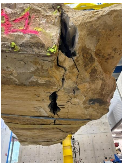
Figuur 40: Scheurvorming en falen proefstuk 1B (3)
