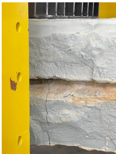
Figuur 34: Scheurvorming en falen proefstuk 1A (1)
