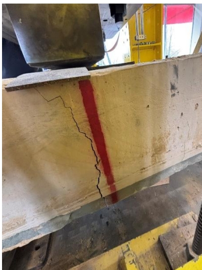
Figuur 44: Scheurvorming en falen proefstuk 2A (1)
