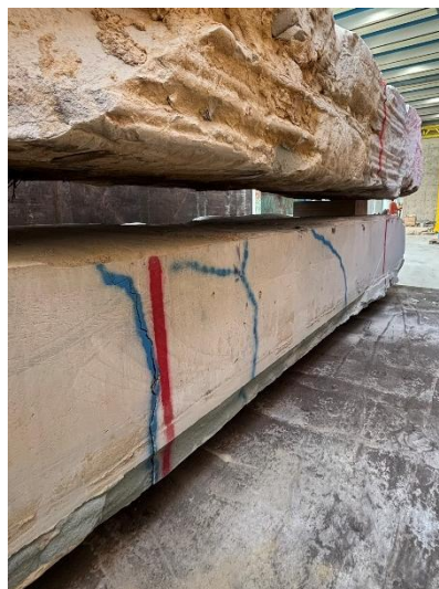
Figuur 47: Scheurvorming en falen proefstuk 2A (4)
