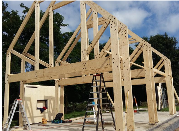
Figuur 16: Schoorconstructies in de houtskeletbouw [50]
