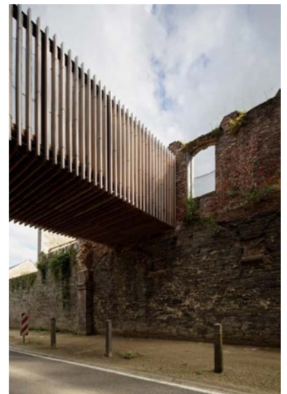
Fig. 29: Loopbrug doorheen het vroegere poortgebouw ©François Lichtle
