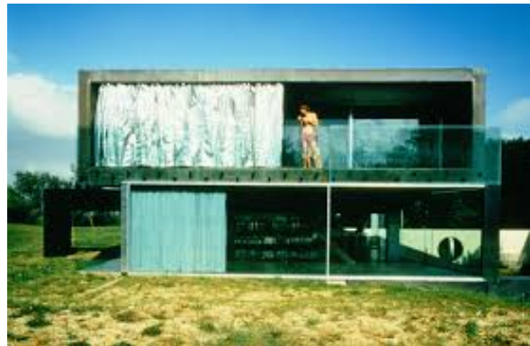
Afb. 52 Maison à Bordeaux
