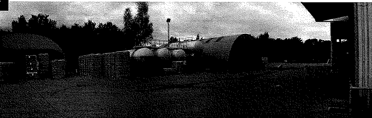
Zicht op de Frisomathallen - stookolieopslag - Romneyhal - toegangszone
