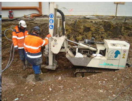
Foto 10: Plaatsing van ISCO-filter
