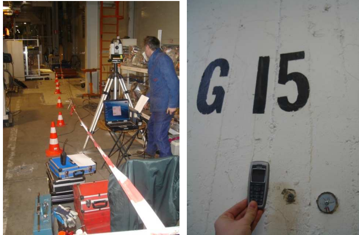
Foto 2: Opmeting van de zettingsbouten in de omliggende gebouwen
