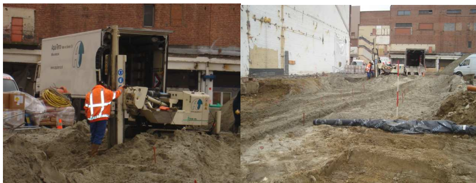
Foto 7: Direct push injecties ter hoogte van de benzeen-styreenzone
