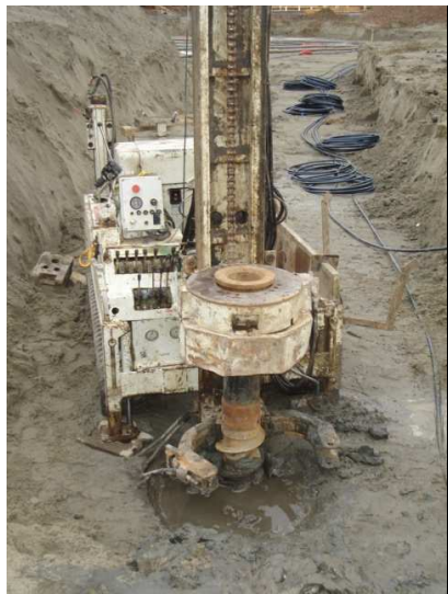
Foto 11: Plaatsing van As-filters
