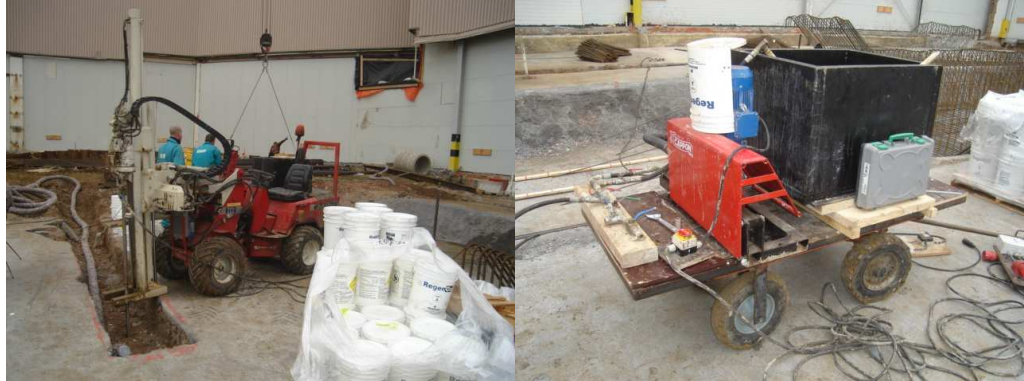
Foto 14: Direct push injecties met RegenOx TM en de menginstallatie
