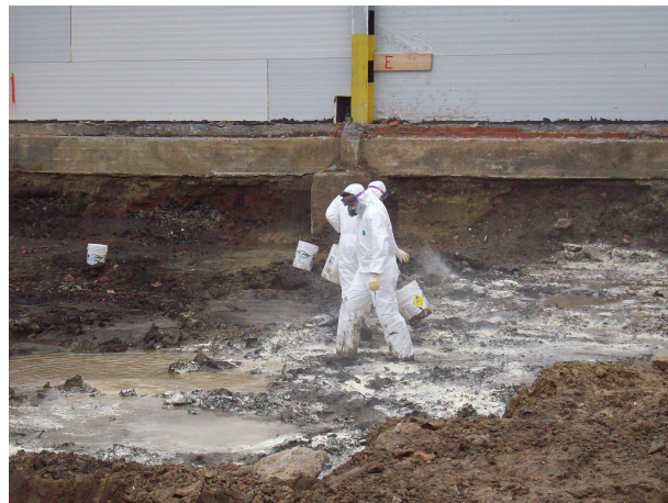
Foto 6: Uitstrooien van mengsel ORC-A™ en IXPEN 75C
