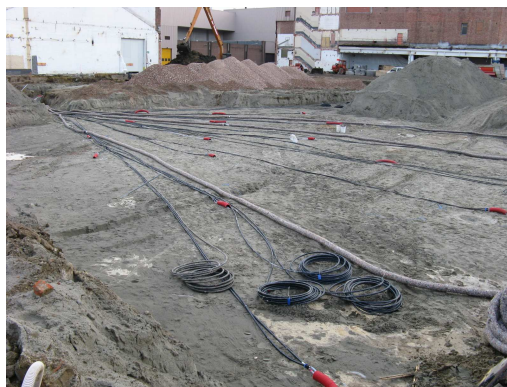
Foto 9: Plaatsing van leidingwerk
